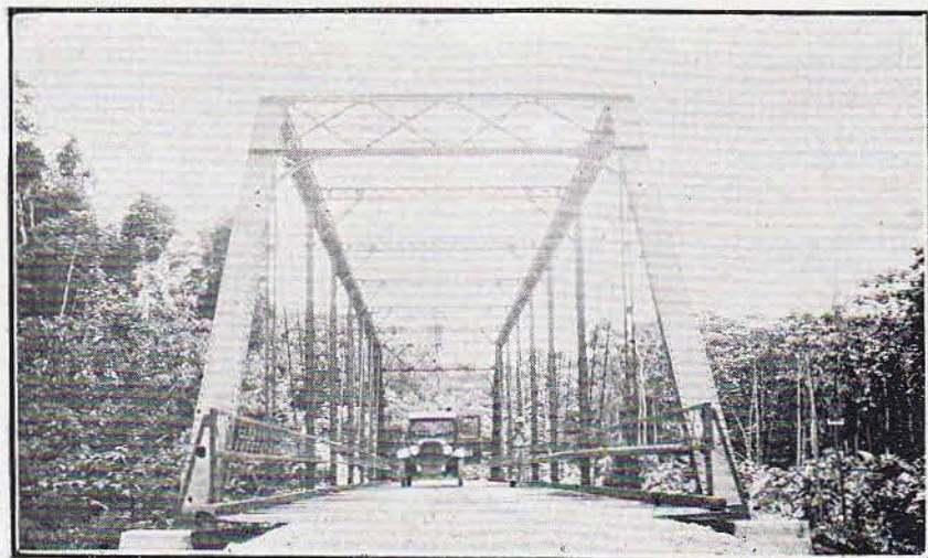
Puente de acero sobre el río Oponcito.
