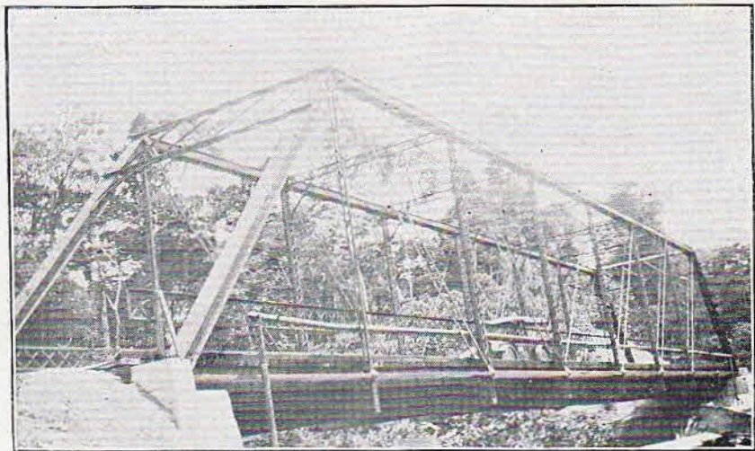
Puente de acero sobre el río Oponcito.
