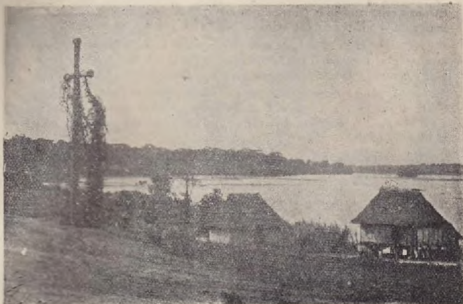
Quinaró. Caserío de veinte casas sobre el río Caquetá.
